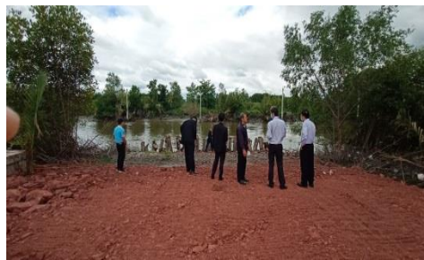
ภาพการลงพื้นที่การสอดส่องโครงการก่อสร้างสะพานคอนกรีตเสริมเหล็กข้ามคลองซุด (พร้อมเชิงลาดเข้าแก้มลิงทุ่งหิน) ตำบลยี่สาร อำเภออัมพวา จังหวัดสมุทรสงคราม งบประมาณ 10,000,000 บาท
